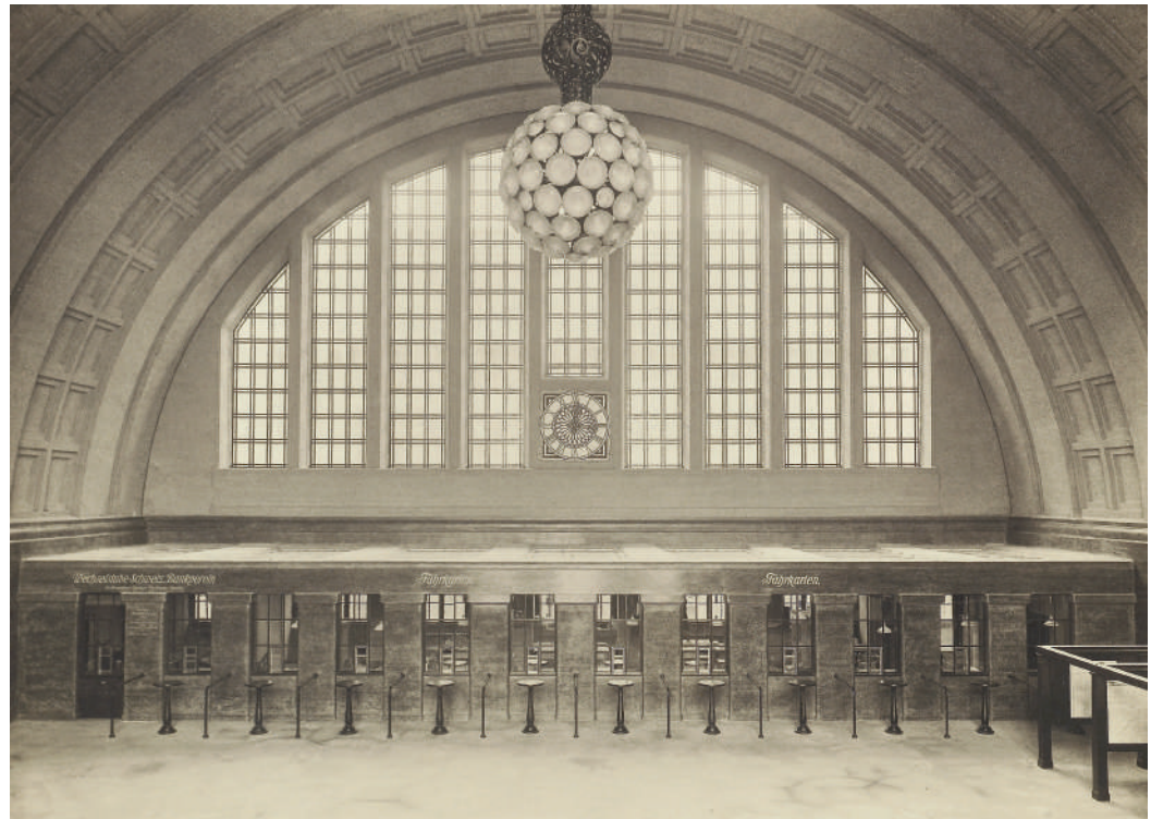
44 (oben) Die grosse Schalterhalle im Badischen Bahnhof ist mit einer imposanten Eisenbetondecke überwölbt. Foto von Philipp Link, 1913.
